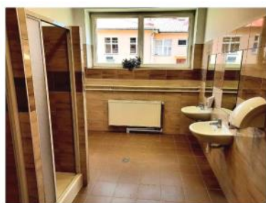
Łazienki po remoncie w bloku sportowym w Szkole Podstawowej w Dwikozach
