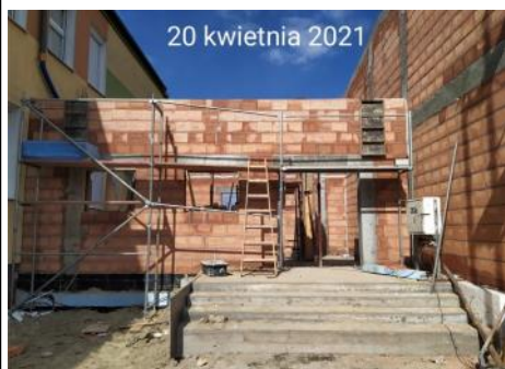
Budowa sali gimnastycznej przy SP w Gierlachowie
