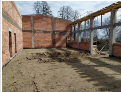
Budowa sali gimnastycznej przy SP w Gierlachowie
